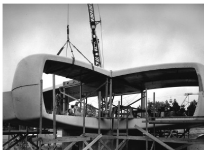
Figura 14 Proceso de montaje de los paneles en obra (Goody Clancy 1957)
