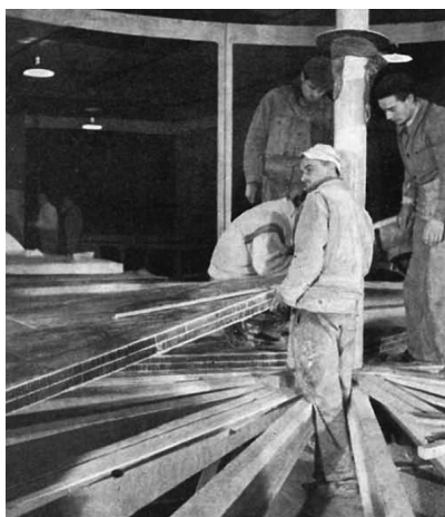
Figura 7 Operarios laminando sobre un molde de madera (Schein 1958)
