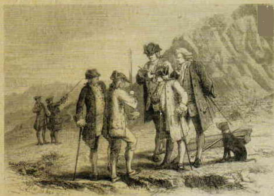
Experimento de Périer en el Puy de Dome para medir la presión atmosférica con un tubo de Torricelli, 1646 (en Louis Figuier, Les merveilles de la science , Vol. 1, 1867).
